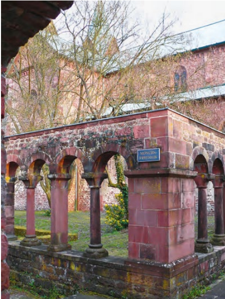
Blick in den alten Mönchsriedhof, dahinter die jetzige Pfarrkirche St. Michael und St. Gertraud. Links davon, leider nicht abgebildet, die Klosterkirche des Missionskloster an der „Neuen Statt“, mit dem noch teilweise erhaltenen karolingischen Vierungsturm der Klosterkirche. Foto: Bernhard Schneider.
